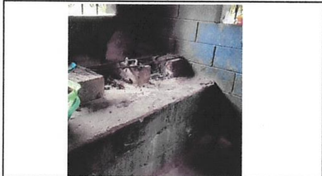
Foto 1: Reconstrucción de plancha y chimenea
