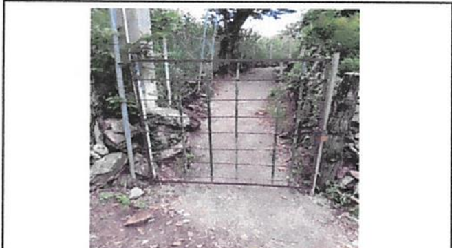
Foto 3: Reconstrucción de dos columnas de 20X20 X 250 de alto
