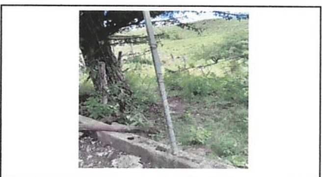
Foto 6: Reconstrucción de muro perimetral que comprende su función de cimiento, levantado de 60 cms de block, colocación de hilada de U fundida y 1.50 mts de malla fundida en U en la parte de abajo, con tubo galvanizado de 1 pulgada horizontal en la parte de arriba y sus respectivos tapones en los tuvos galvanizados
