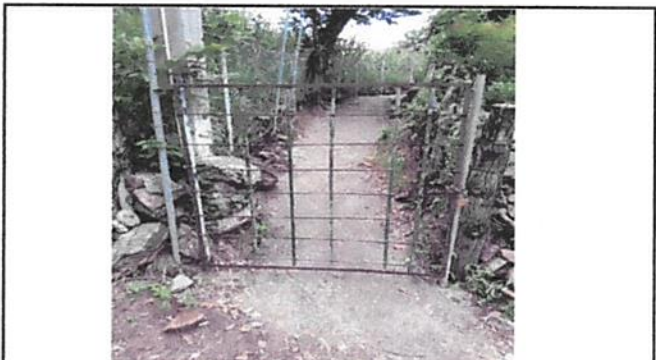
Foto 4: Reconstrucción de portón para ingreso del establecimiento de 1.10 metros por 2.00 metros
