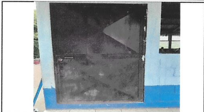
Foto 2: Mantenimiento de cuatro puertas, reparación, limpieza y chapa
